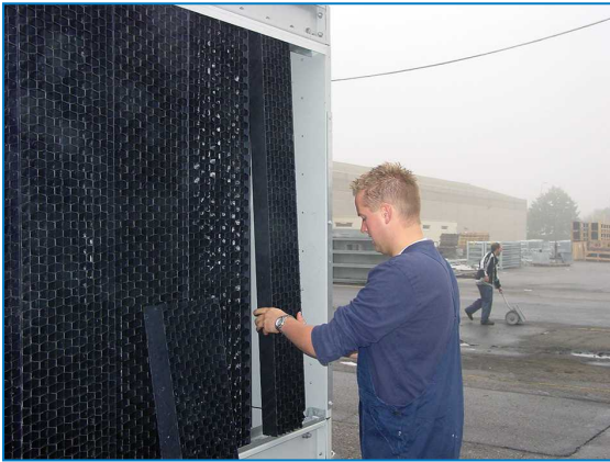
Démontage des déflecteurs d'entrée d'air
