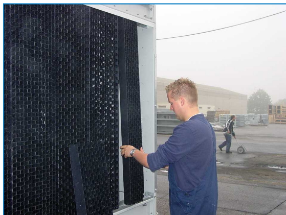
Démontage des déflecteurs d'entrée d'air
