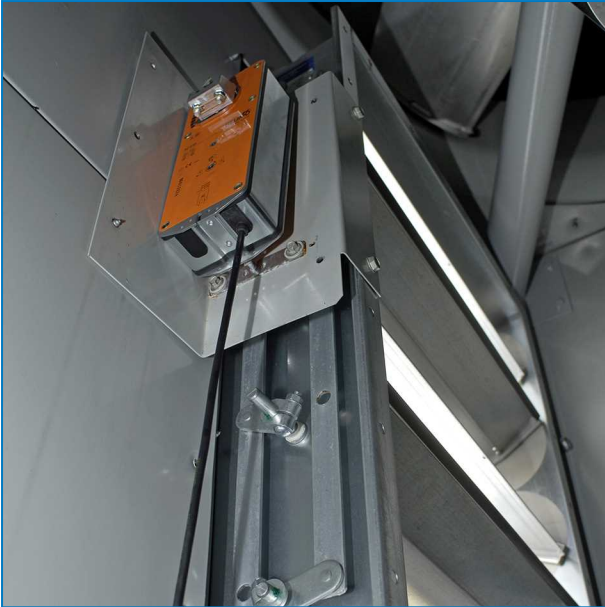
Servomoteur pour des registres de modulation d'entrée d'air
