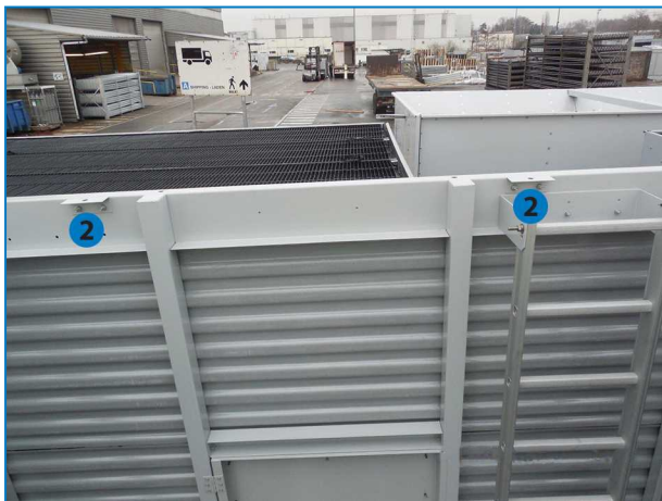
2. Guía/soporte de izado de la sección inferior
